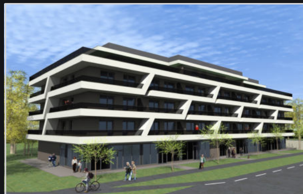
University Residence társasház - Debrecen Gree Multi és Monosplit 275 kW
