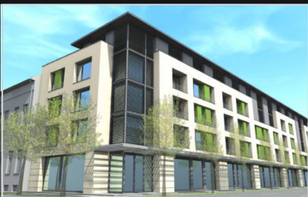
Arany Residence társasház - Debrecen Gree Multi és Monosplit 680 kW
